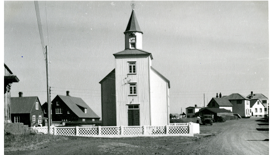
Mynd 9: Eyrarbakkakirkja um 1950, með bárujárnsklæðningu og steipt grindverk í kring. Heimild Héraðsskjalasafn Árnesinga.
